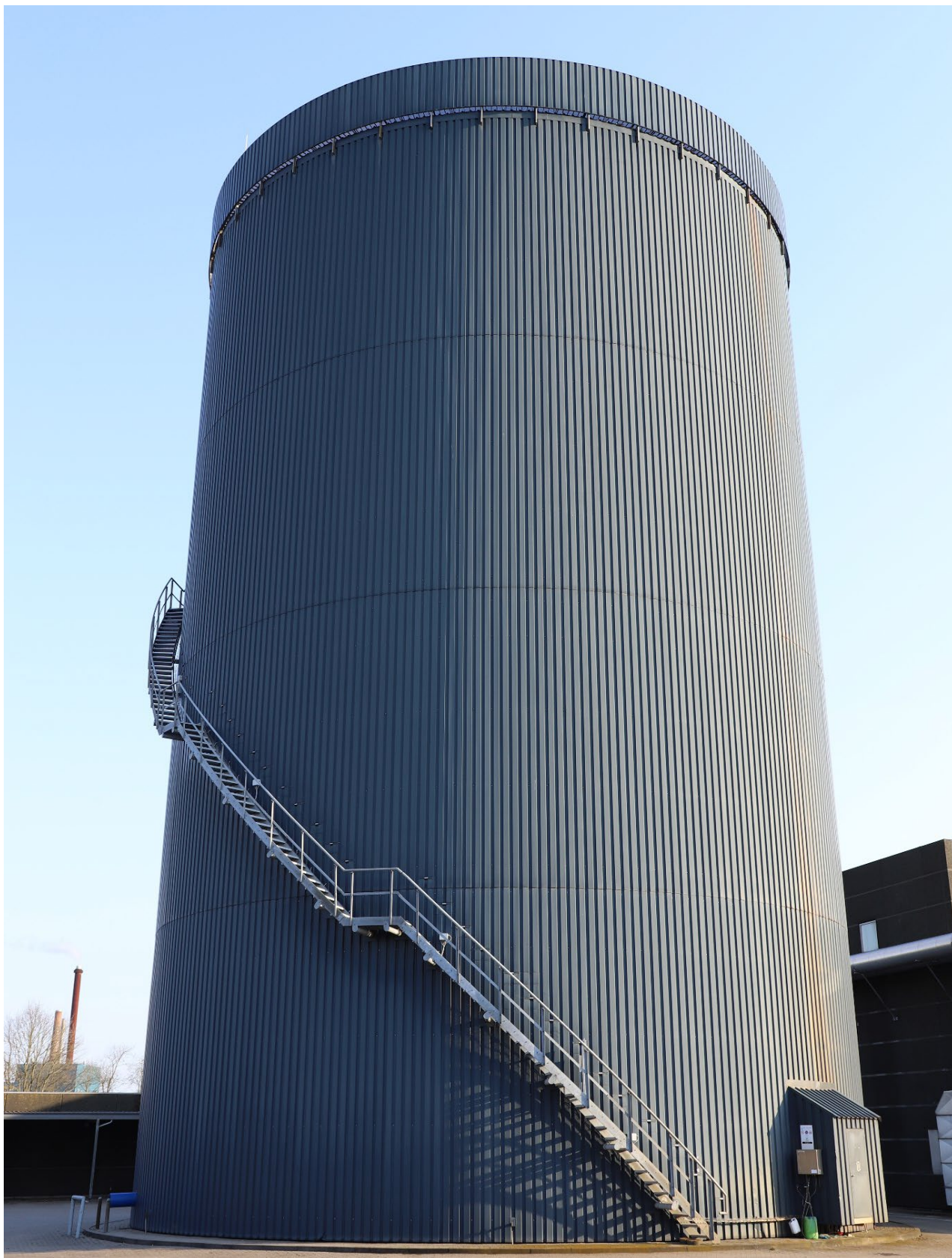
Akkumuleringstank. Foto: GEV
