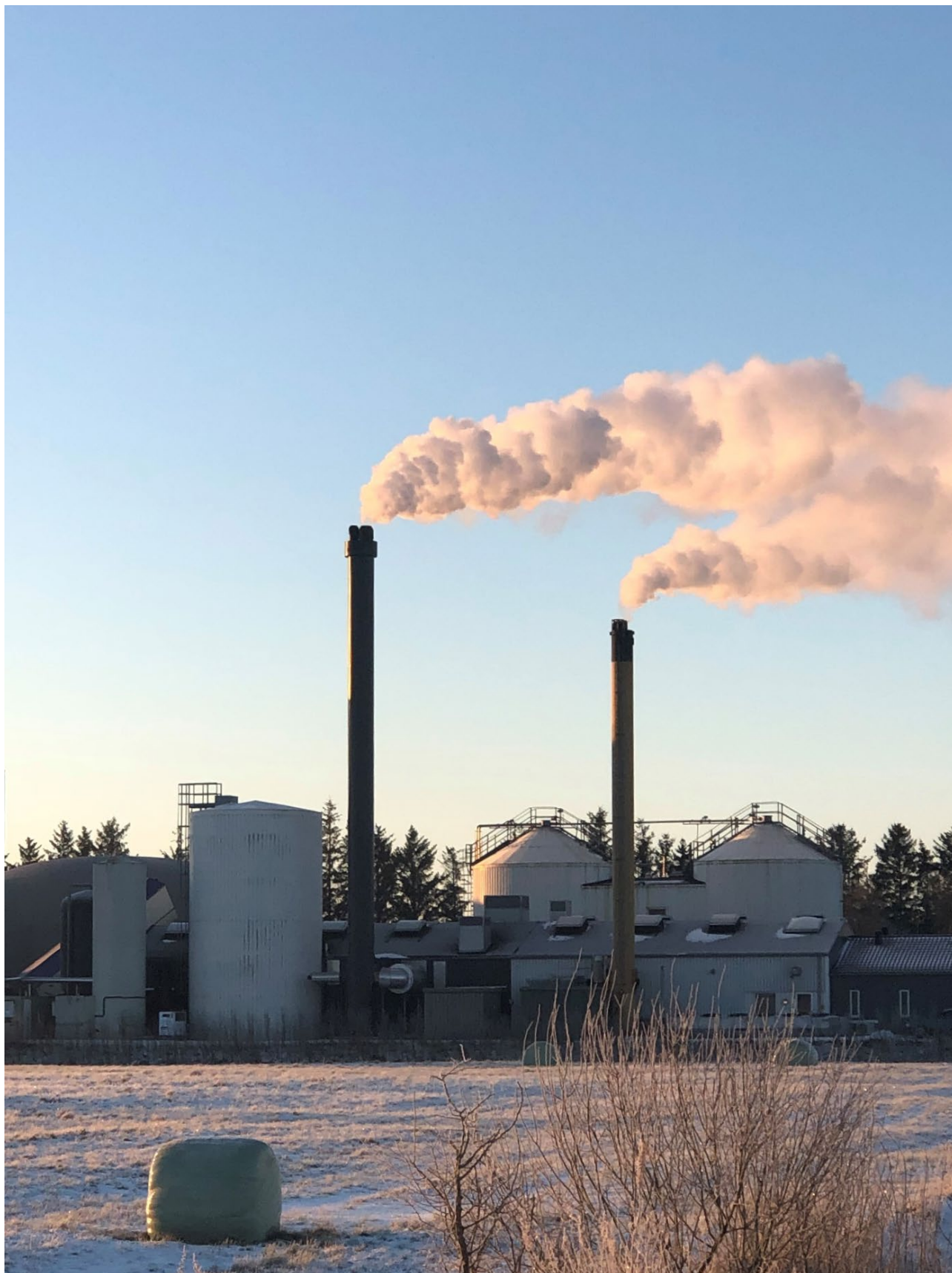
Varmeværk. Foto: Filskov Energiselskab
