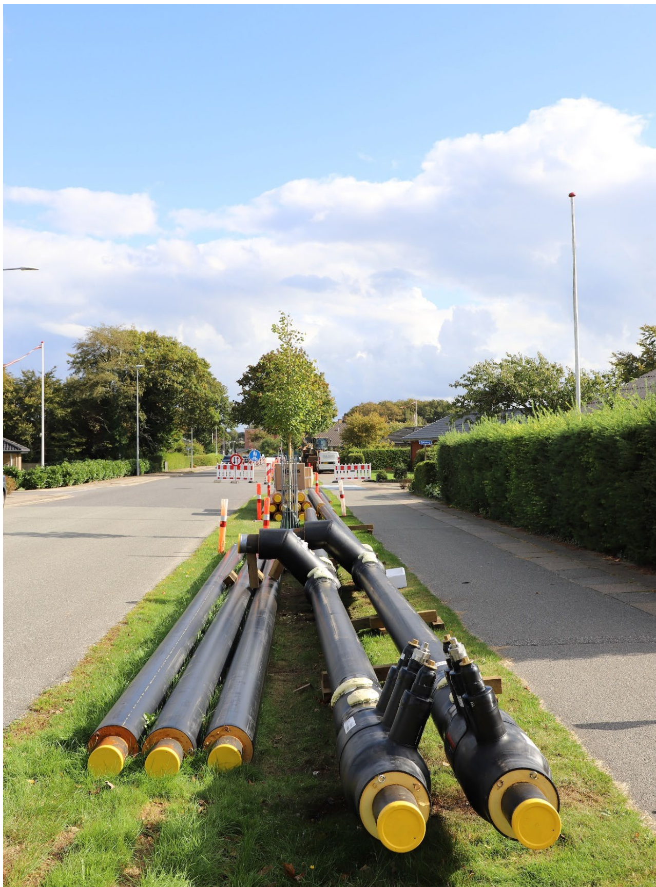
Fjernvarmerør klar til nedgravning. Foto: GEV
